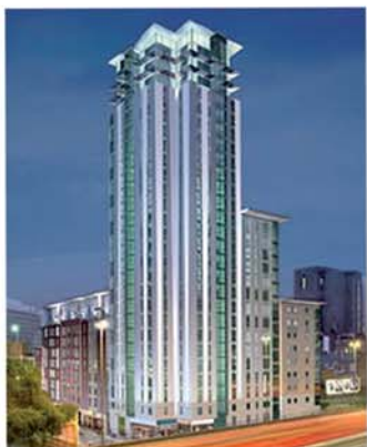
The Orion building - 442 lokali. Birmingham - WIELKA BRYTANIA
